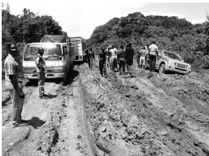
Slechte conditie van de Afobakaweg vóór de asfaltering in 2010 (foto Eleonora Zito)
